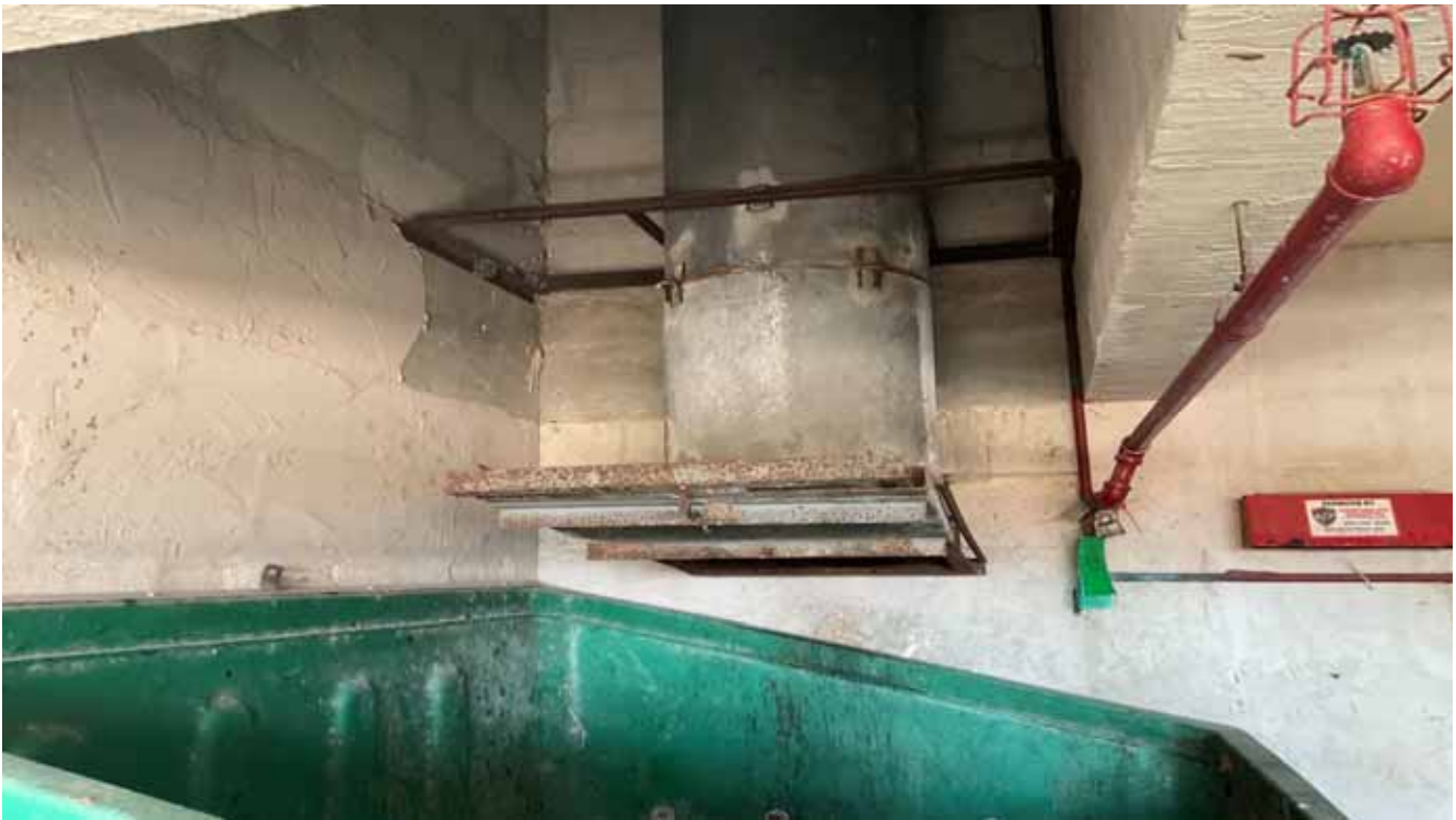
2300 Bldg - Trash Chute
