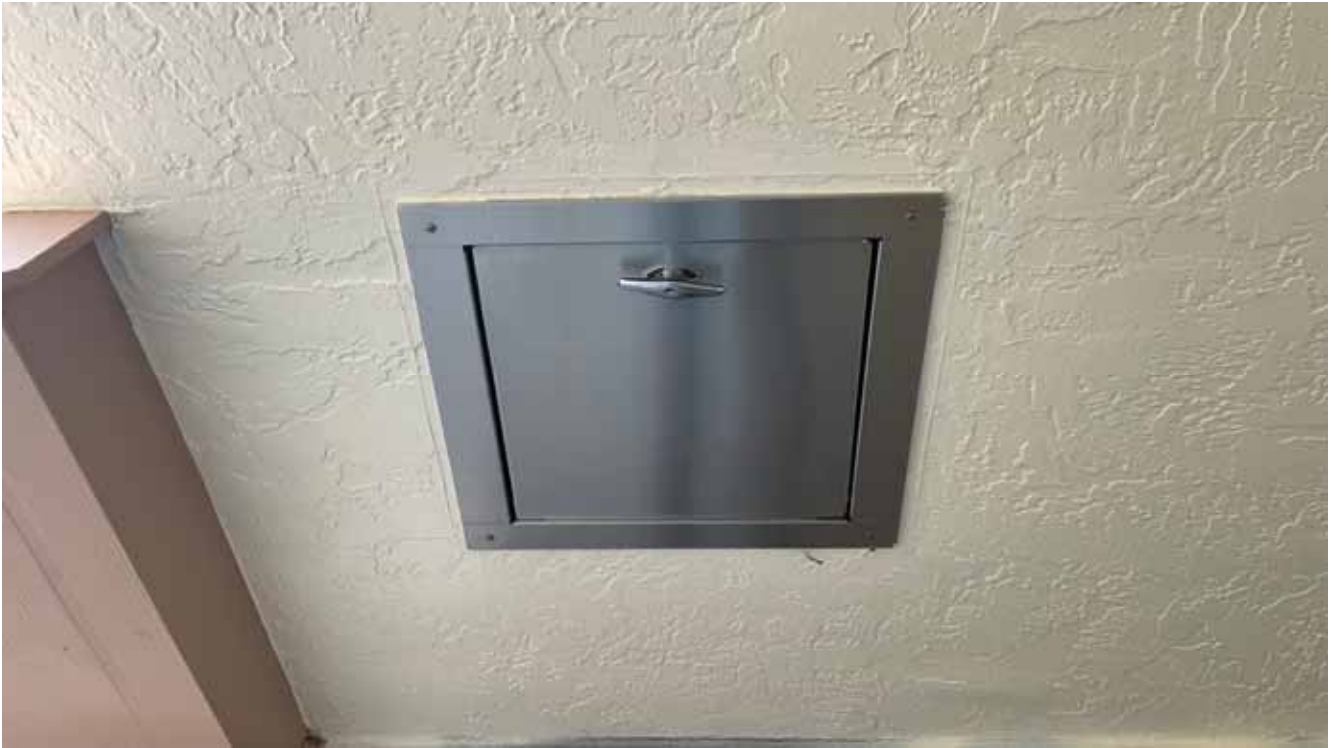
2300 Bldg - Trash Chute
